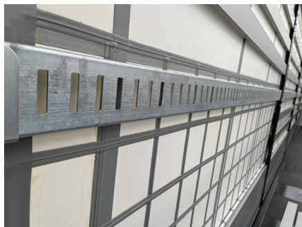
Stalowa konstrukcja boczna
