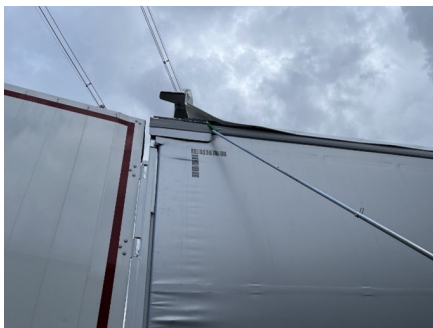
DPodnoszenie dachu od zewnątrz
